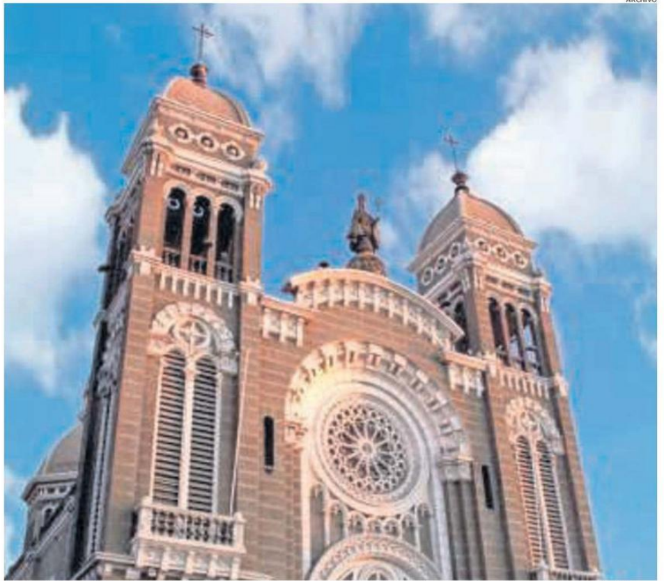
LAS OBRAS EN LA BASÍLICA SON UN EJEMPLO DE LOS INMUEBLES QUE DEBEN SER MEJORADOS, PERO SUS LICITACIONES HAN QUEDADO DESIERTAS.
